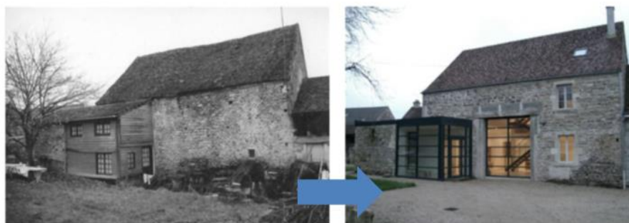
Figure 1. Illustration du changement de destination d'une grange en habitation
