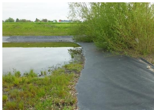
Photo 1. Bassin de rétention d'eau colonisée par une végétation et fourré ripicole, sur site
