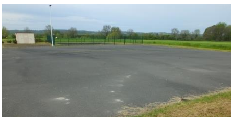
Photo 6. Bâti et zones carrossables, sur site
